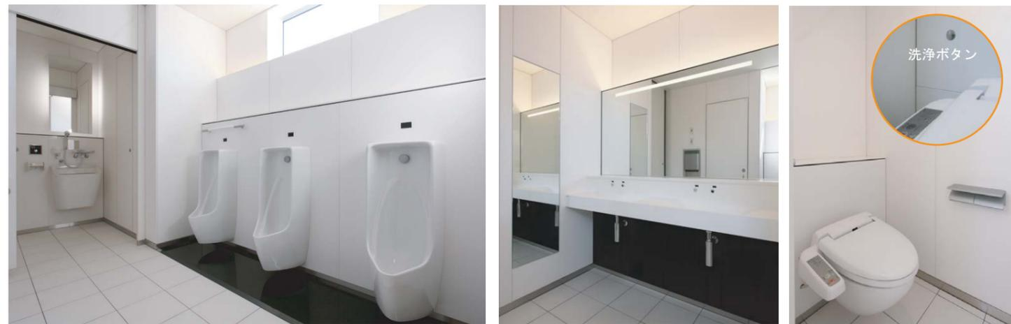
洗面器はボウルからカウンター、バックガードまで連続性を持たせたNOSELカウンターを採用。大便器の洗浄ボタンのプレートや、小便器手すりの固定部を埋め込み、色は白に統一したことで、シンプルですっきりとした空間を生み出している。また、洗面カウンター下部は車椅子での利用を考慮し前板をセットバックさせている。
